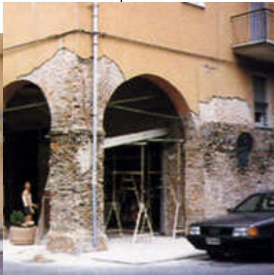
Demoler el revoque
