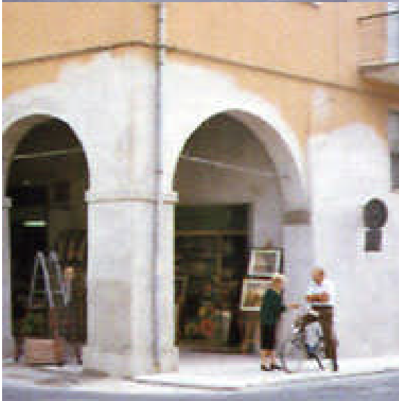
Revoque con Socymur
