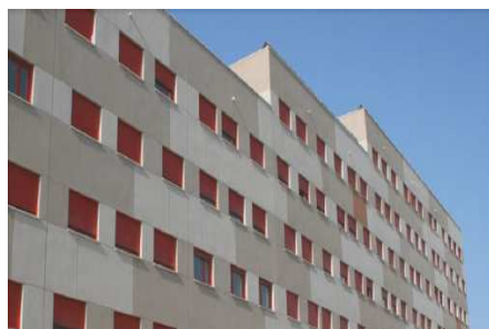
Sistema SATE- ETICS obra nueva
