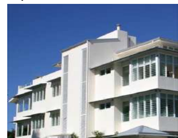
Sistema SATE - ETICS rehabilitación
