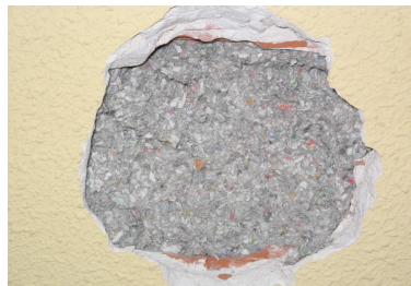
Celulosa insuflada en cámara
