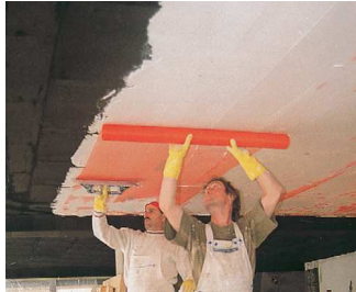
Rehabilitacion Interior sin obras y en edificios con patologias.
