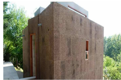
Sistema SATE corcho sin revestir a la intemperie
