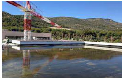
EPDM RESITRIX autoadhesivo. Prueba de estanqueidad
