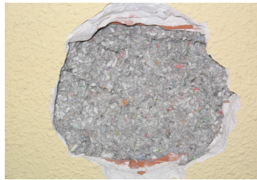
Celulosa insuflada en cámara
