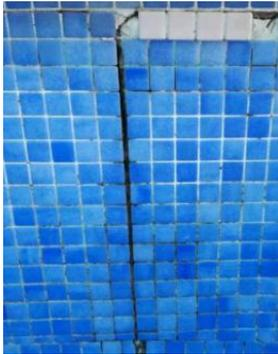
En los vasos de piscina de hormigón armado se producen a menudo fisuras y grietas por movimientos de retracción. Una vez reparadas las grietas y fisuras existentes, para asegurar la impermeabilidad del vaso se debe revestir con la lámina **SOCYEVA POOL**, ya que es capaz de absorber estos movimientos de retracción y asentamiento.
