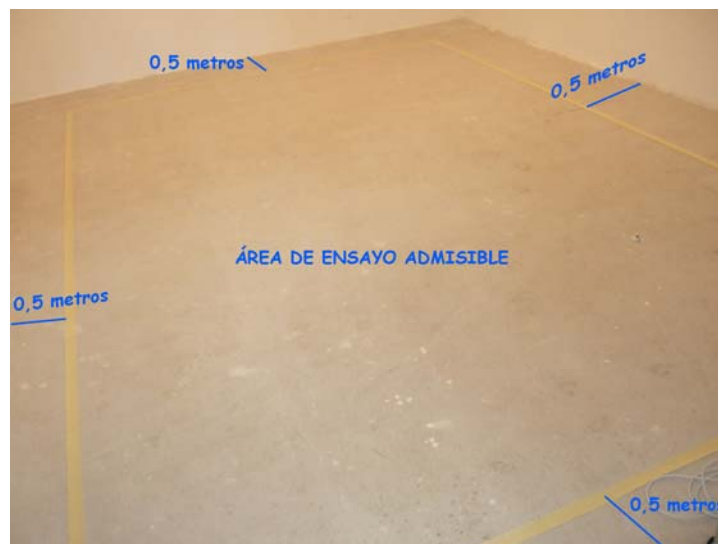
Fotografía 1. Área de ensayo admisible sobre la losa de hormigón normalizada.
