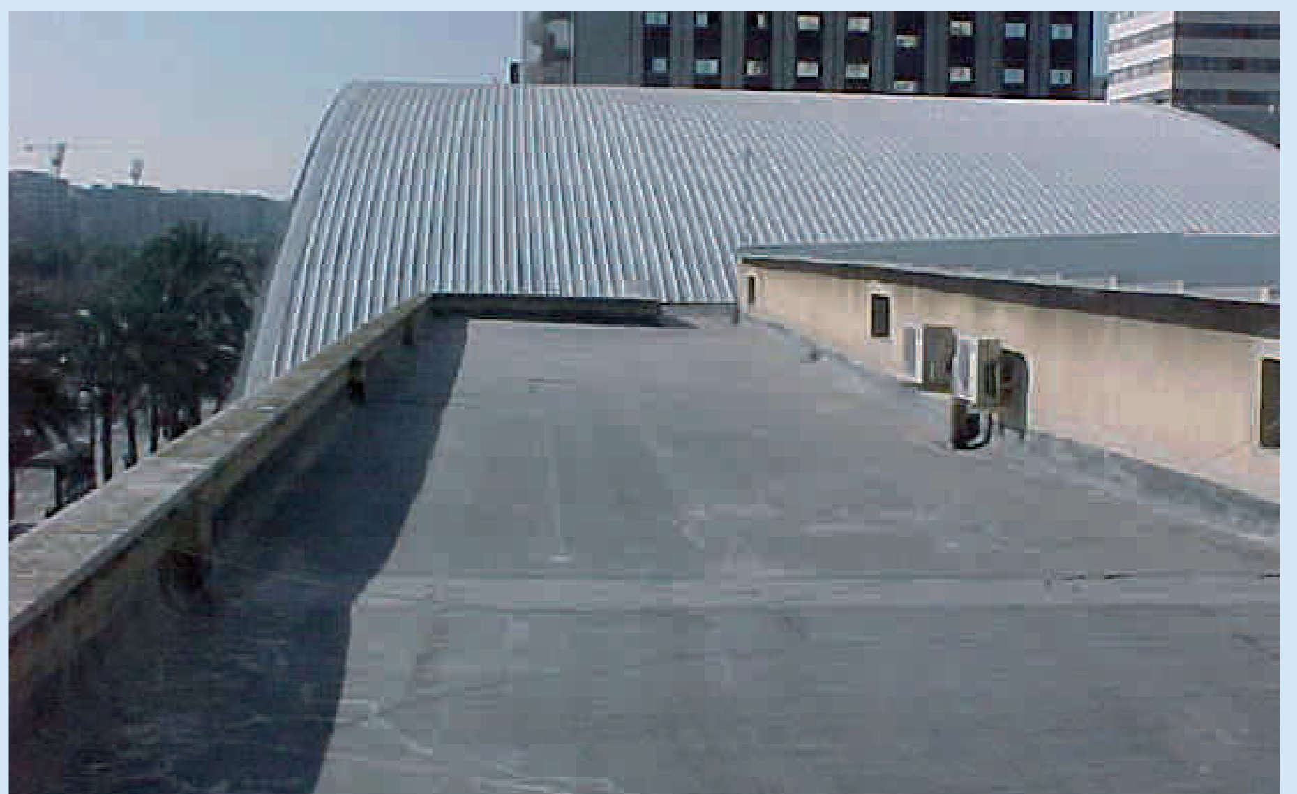
Estación de autobuses Valencia, adherido totalmente
