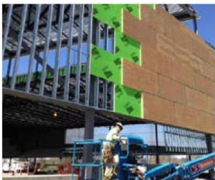
Rehabilitación de Fachadas S.A.T.E. Cerramiento de Fachada
